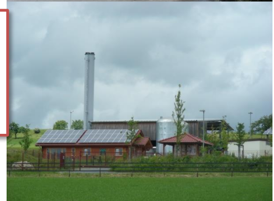
목재분 저장 및 Heating Plant.
